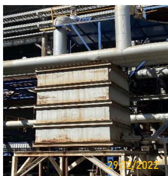
ภาพที่ 14 การติดตั้งอุปกรณ์ลดเสียง (Silencer) บริเวณวาล์วที่มีเสียงดัง
