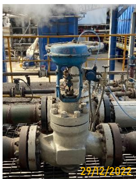
ภาพที่ 44 การติดตั้ง Control Valve
