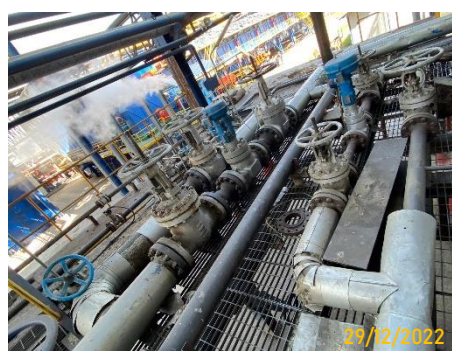
ภาพที่ 45 การติดตั้ง Bypass Valve
