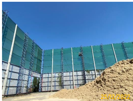
ภาพที่ 7 โครงเหล็กและตาข่ายโดยรอบ บริเวณพื้นที่ลานกองขานอ้อย
