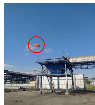
ภาพที่ 54 ถุงลม (Wind Sock) บริเวณไซโลเก็บเถ้า
