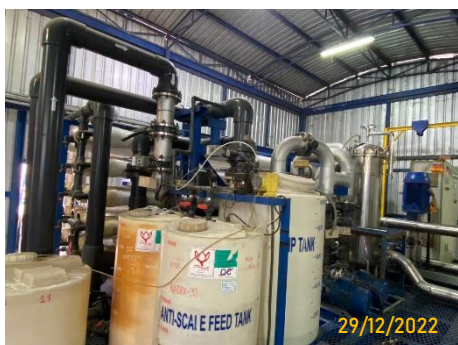
ภาพที่ 19 กระบวนการรีเวอร์สออสโมซิส (Reverse Osmosis)
