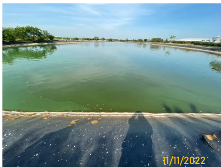
ภาพที่ 21 บ่อระบบบำบัดน้ำเสียแบบ Lining
