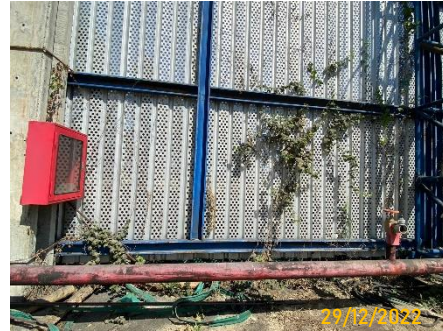
ภาพที่ 49 การติดตั้งสายฉีตดับเพลิง โอบรอบลานกองขานอ้อย
